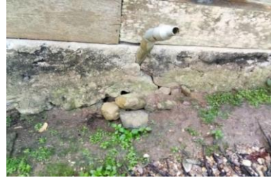
gambar bagian pondasi rumah yang retak Kardin Tenggeli
