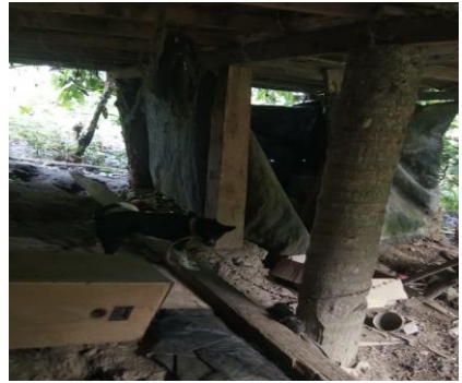
Gambar pondasi rumah ibu berlian tenggeli yang terlihat miring / tidak rata lagi
