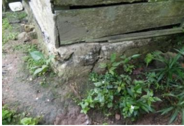
gambar bagian pondasi rumah yang retak Kardin Tenggeli
