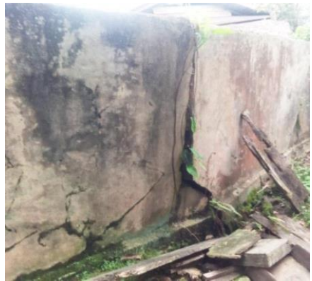
gambar gereja GKST Efrat Sulewana dinding gereja dan pagar belakang mengalami retak dan potensi roboh.
