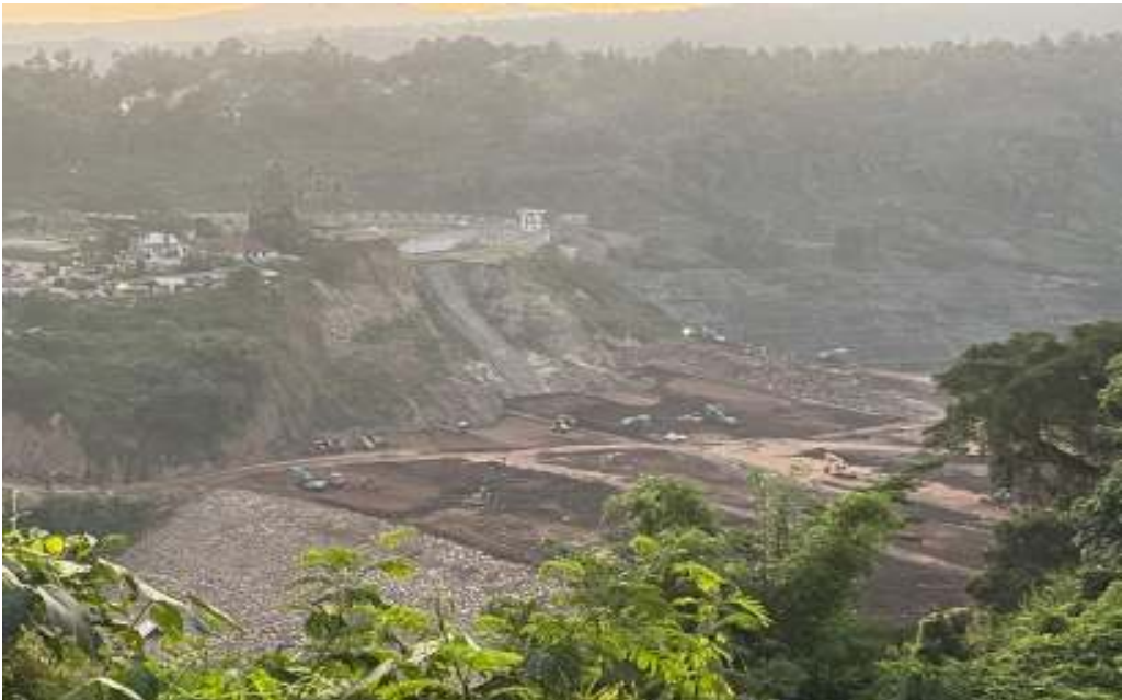
(Dokumentasi SP Mataram, Kondisi Pembangunan Bendungan Meninting pada 12 Juni 2024, masih belum terlihat bentuk kolam embung tampungan)
